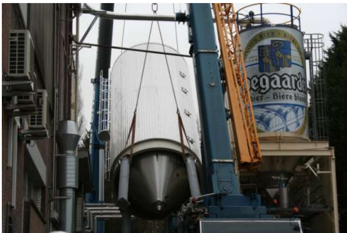
Figuur 1 De nieuwe gistingstanks worden naar boven gehesen
